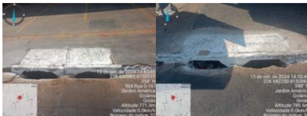
Figura 12 e Figura 13. Pontos 3 e 4 com sistemas conjugados, do tipo chapéu
