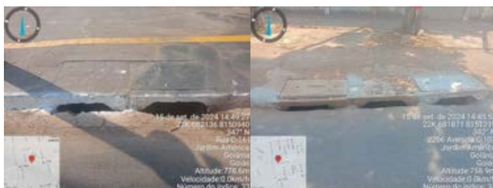
Figura 16 e Figura 17. Pontos 7 e 8 demonstrando a obstrução parcial da entrada da água e ressalto da soleira
