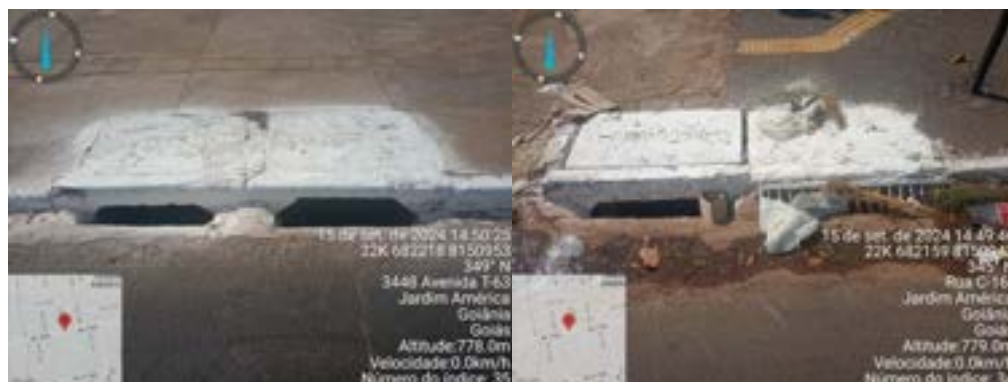
Figura 16 e Figura 17. Pontos 7 e 8 demonstrando a obstrução parcial da entrada da água e ressalto da soleira
