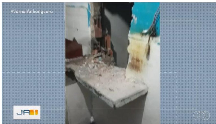
Figura 05: Situação de cela na CPP.
