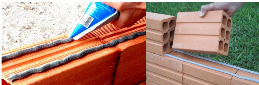
Figura 3 – Exemplos de execução com argamassa polimérica
