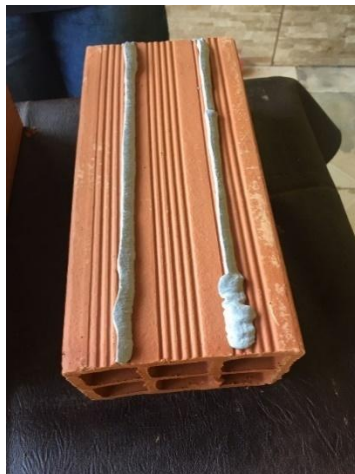
Figura 15 – Aplicação da argamassa polimérica – 2 cordões
