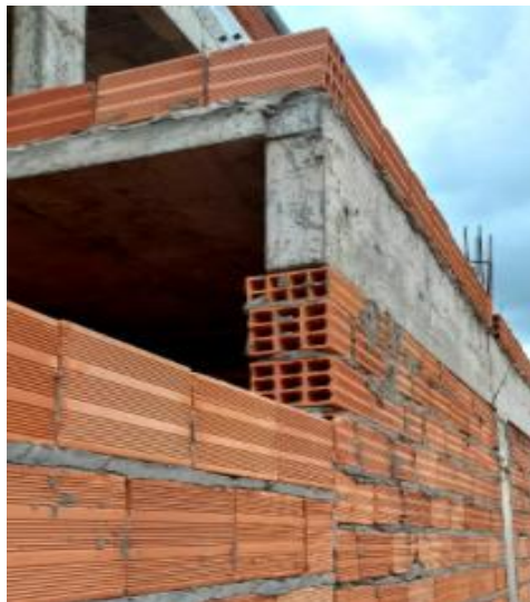
Figura 12 – Exemplo de blocos assentados a uma vez
