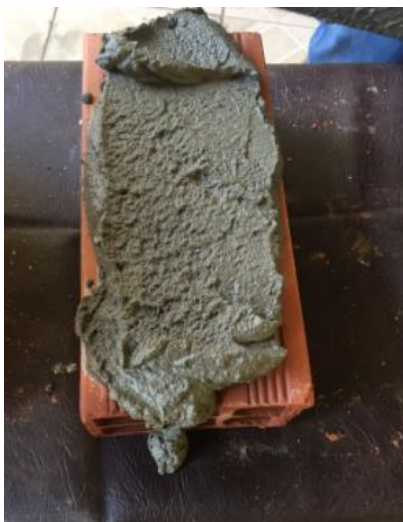
Figura 18 – Aplicação da argamassa convencional
