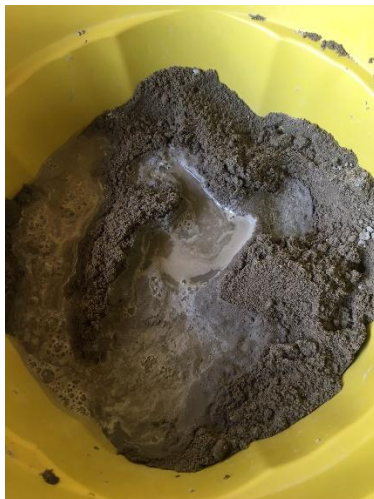
Figura 17 – Preparação da argamassa convencional
