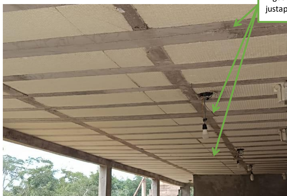
Figura 2 – Laje do pavimento superior.
