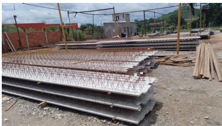
Figura 6 – Laje pré-fabricada treliçada.
