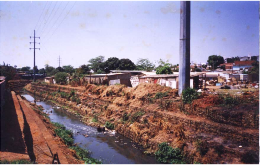
Figura 2. Trecho do Córrego Capim Puba, próximo ao antigo Morro do Aranha, onde o adensamento populacional vem provocando a poluição das águas devido ao lançamento de esgoto e lixo (Goiânia).
